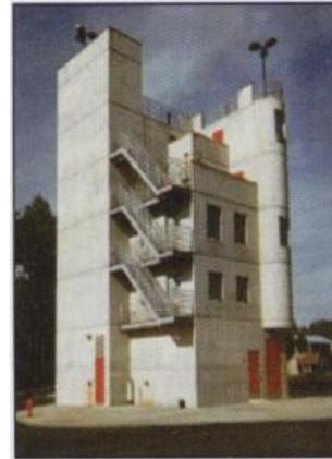
Scala in vano compartimentato da strutture tagliafuoco comunicante con uno spazio aperto
